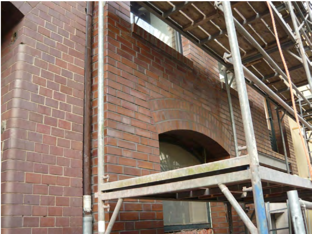
Segmentbogen aus 3 übereinanderliegenden Rollschichten
