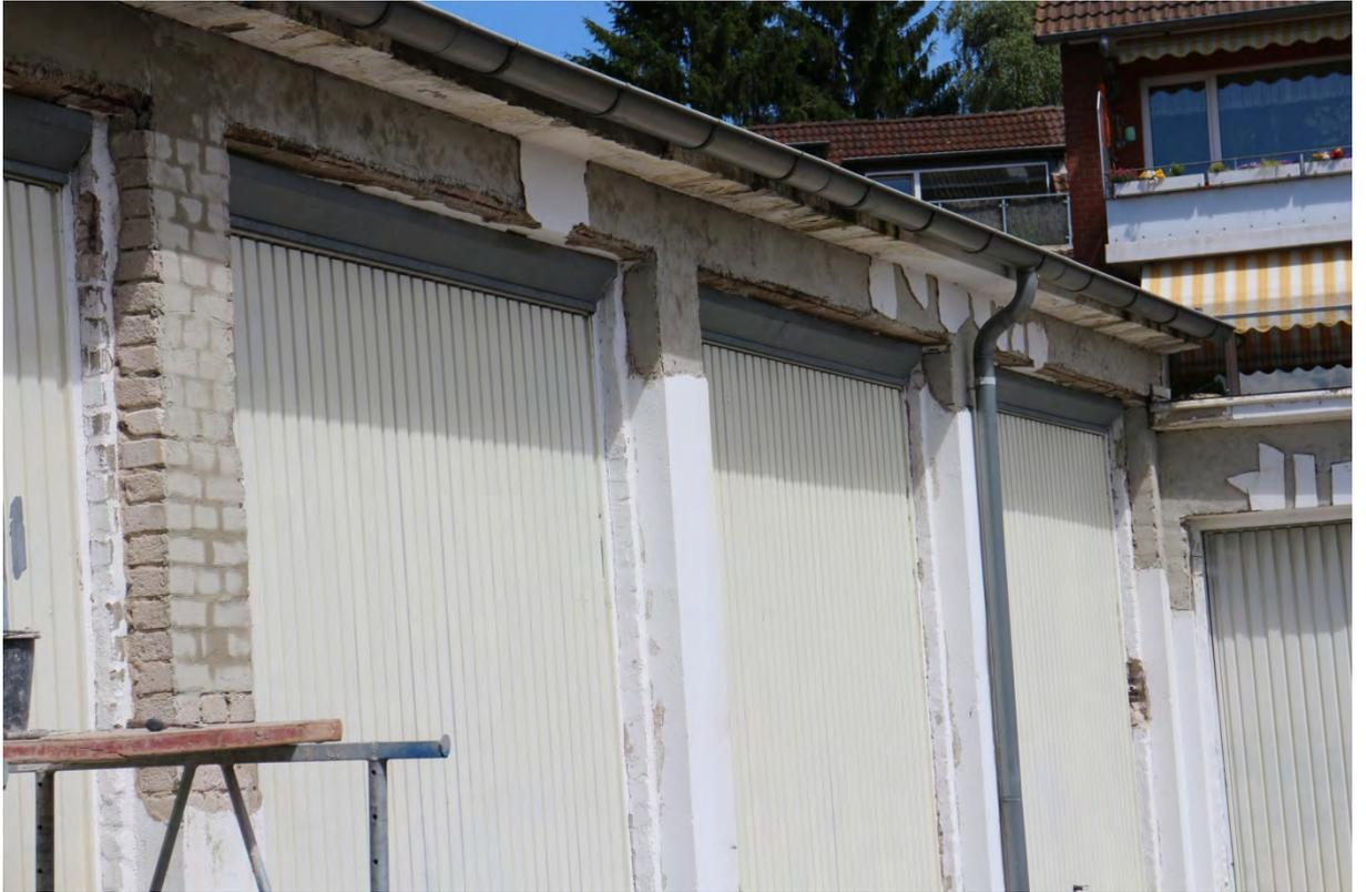
Riss- und Putzinstandsetzung der Garagenfassade
