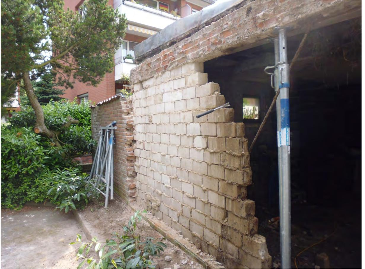
Abbruch der durch Feuchtigkeit geschädigten Garagenrückwand
