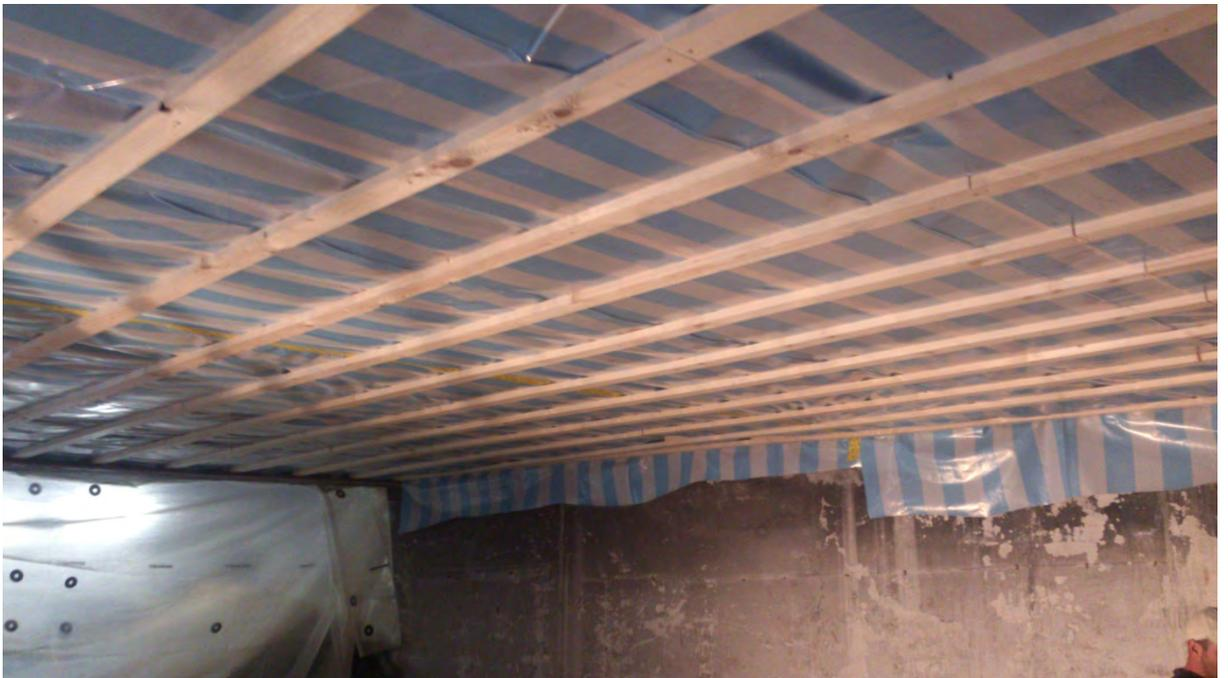
Neue Dachkonstruktion einschließlich Dämmung und Dampfsperffolie im Zuge der Trockenbauarbeiten
