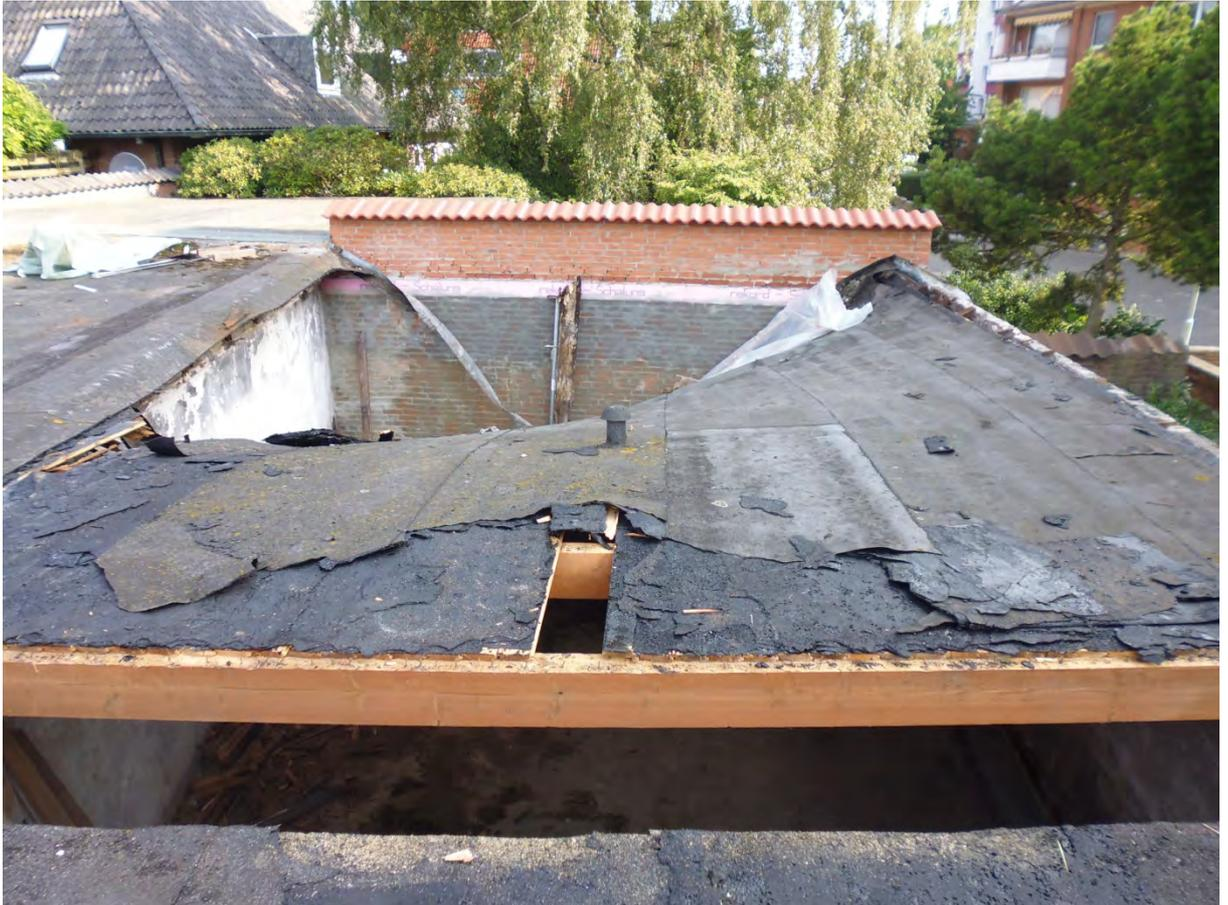
Abbruch der durch Feuchtigkeit beschädigten Dachkonstruktion
