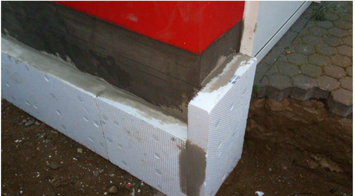
Sockeldämmung und Abdichtung der Fassade
