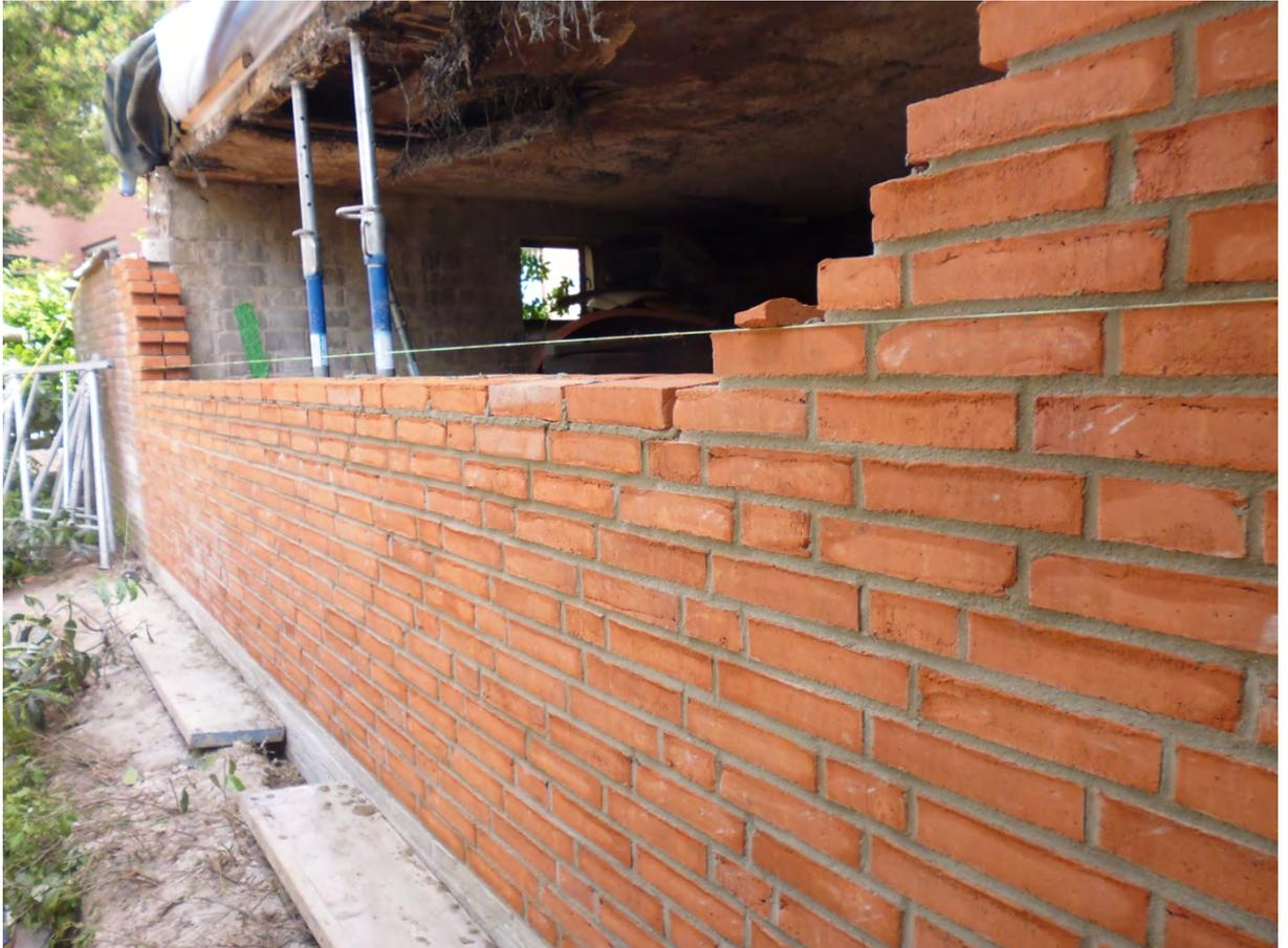
Herstellen der neuen Rückwand als Sichtmauerwerk
